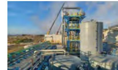
Utiliza tecnologías de vertido cero, la primera de este tipo en España. Permite la recuperación de los efluentes para su uso en el proceso, reduciendo el consumo de agua. Contempla el tratamiento de cuatro tipos de corrientes distintas. Capacidad: 1.870 m<sup>3</sup>/d. Sector: minero-metalúrgico.
