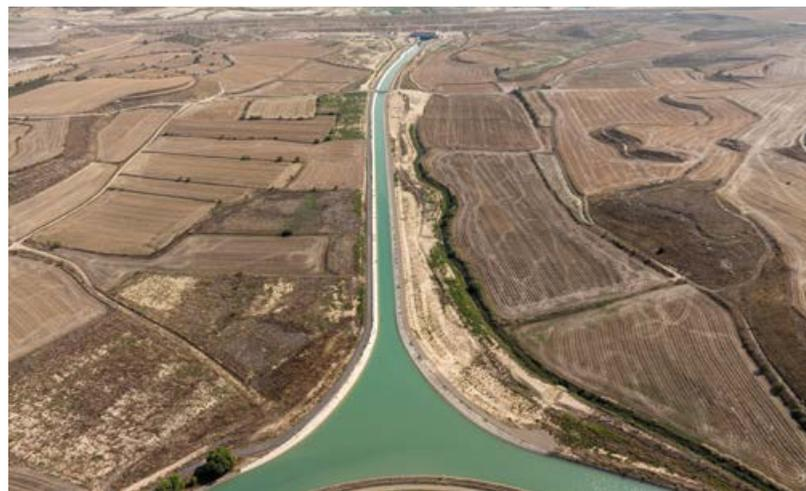
Proyecto y ejecución de un embalse con dos presas (diques) de materiales sueltos para almacenamiento de 170 Hm<sup>3</sup> de agua y una superficie de inundación de 1.152 hectáreas al nivel normal. Incluye un canal de aducción, estación de bombeo y sub-estación eléctrica de intemperie.
