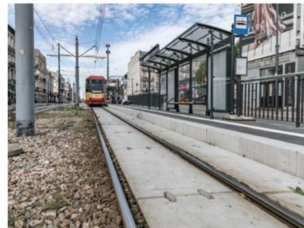
Demolición del pavimento existente y retirada de la superestructura del tranvía. Remodelación y adecuación de las redes de servicios al nuevo tramo tipo. Construcción de las losas de la línea tranviaria, instalación del alumbrado urbano, catenaria y arbolado.
