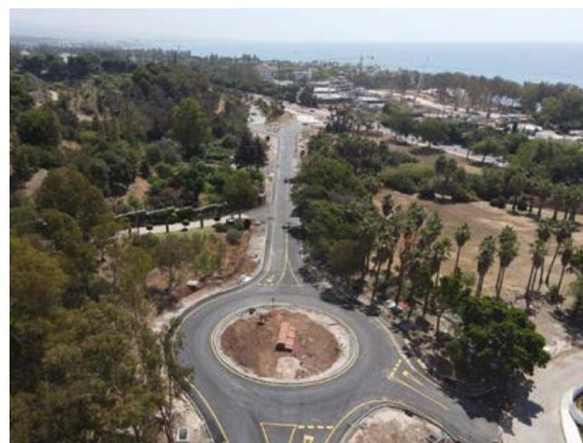
Acondicionamiento del tramo comprendido entre los pp. kk. 0+000 y 1+900, mediante una sección transversal homogénea en todo el recorrido, así como la mejora del trazado de la carretera.
