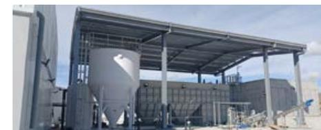
Estación de tratamiento de aguas regeneradas. Homogeneización, decantación lamelar, ultrafiltración, desinfección por ultravioleta y tratamiento de los lodos con tornillo deshidratador. Capacidad: 1.640 m<sup>3</sup>/día. O&M: cinco años. Sector: áridos.
