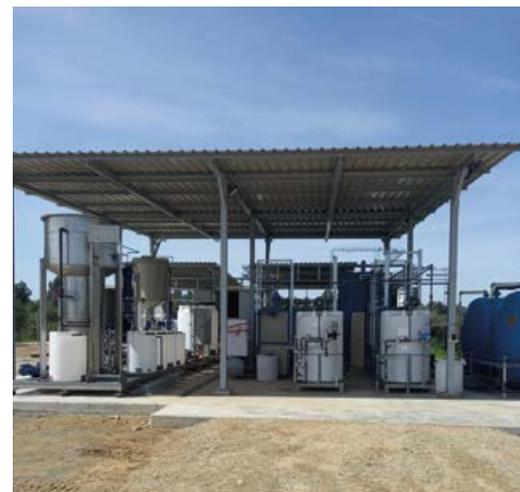
Ingeniería, fabricación, suministro, montaje y puesta en marcha de una planta piloto para el tratamiento de aguas ácidas de contacto procedentes de antiguas operaciones mineras en Aznalcóllar, con el objetivo de recuperar cobalto, tierras raras y otros metales como el zinc.
