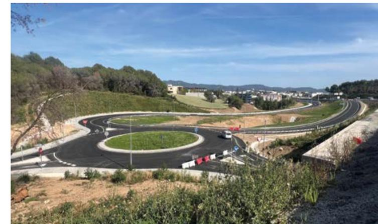
Eliminación de las conexiones con el polígono industrial "Font del Ràdium" y construcción de un nuevo enlace a la altura del polígono de Can Montcau. Se habilitan carriles de trenzado en ambos sentidos entre los enlaces con la C-352 y el nuevo enlace de Montcau.
