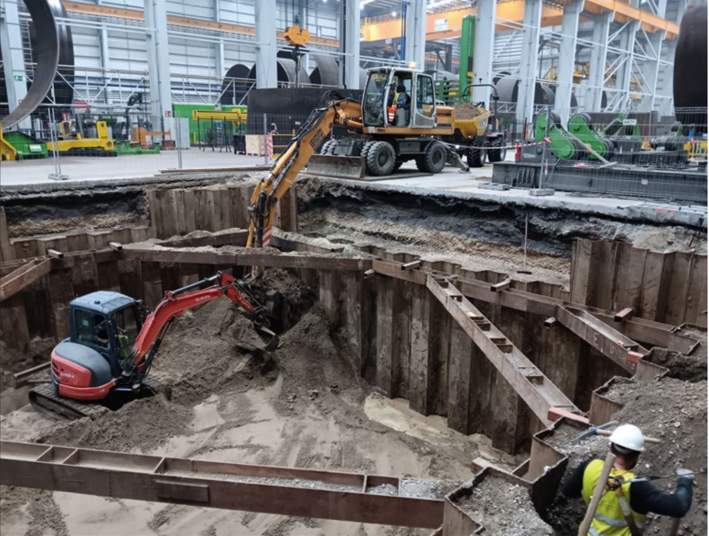
▲ Obras civiles, gestión de suministros y alquiler de maquinaria para nave de producción de monopiles en Puerto de Bilbao
