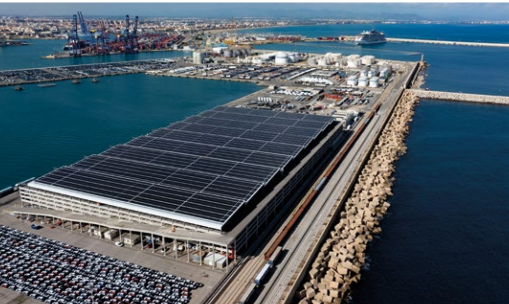
▽ Instalación de autoconsumo en el Puerto de Valencia
