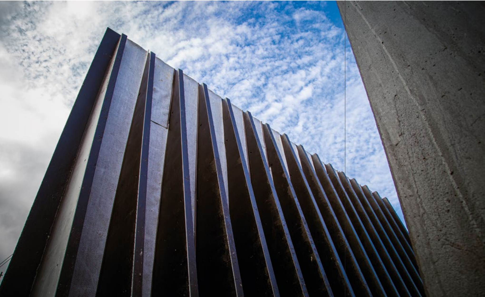
▼ Conexión entre la LAV Madrid-Levante y LAV Madrid-Barcelona en el término municipal de Madrid. Fase 2
