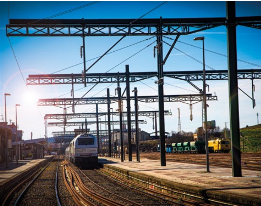
▽ Electrificación AVE Plasencia - Peñas Blancas
