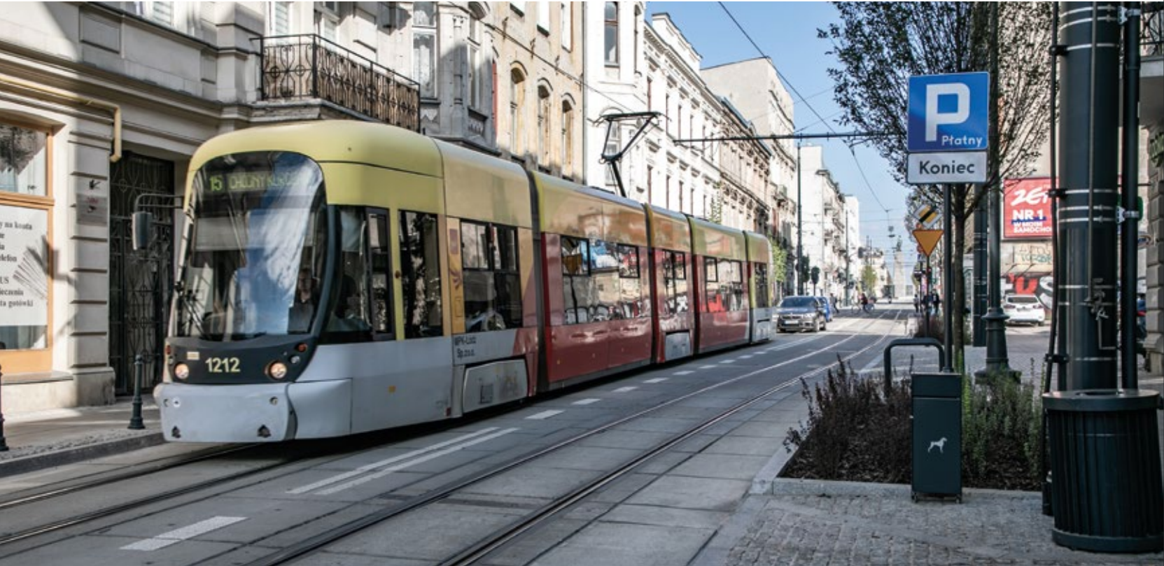
▼ Línea de tranvía de Lodz. Calle Legionow. Tramo I, tramo II, tramo III (Polonia)
